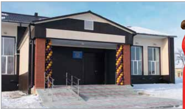
Отремонтированный Дом культуры
